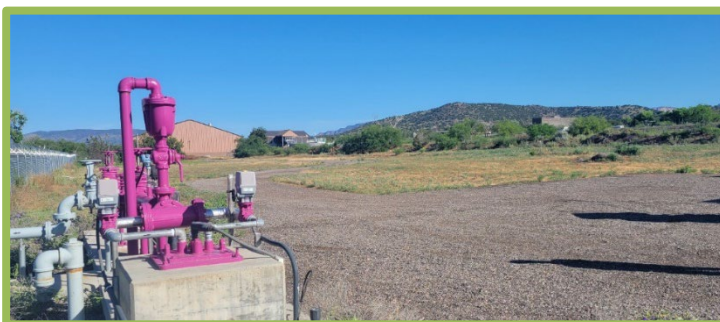
Pozo de recarga del acuífero en la Instalación de Tratamiento de Aguas Residuales de Sedona. La adición de dos pozos de inyección de agua, bajo el permiso general 3, ha permitido que la ciudad recargue 273.000 galones de agua por año.
